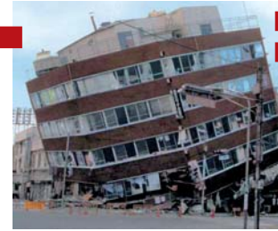
Abb. 5: Erdbebenschaden (Kobe Japan 2005). Quelle: H. Bachmann
