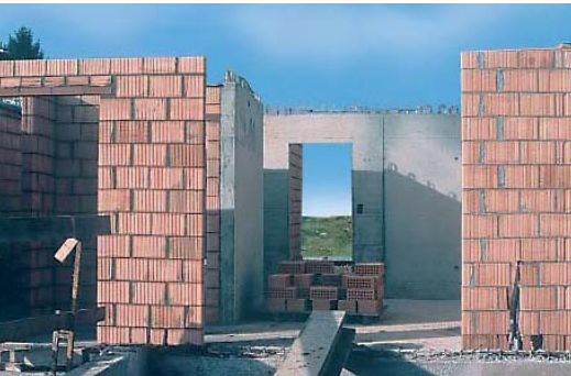
Abb. 7: Wohnblock als Mauerwerksbau, ausgesteift mit Stahlbetonwänden. Quelle: T. Wenk
