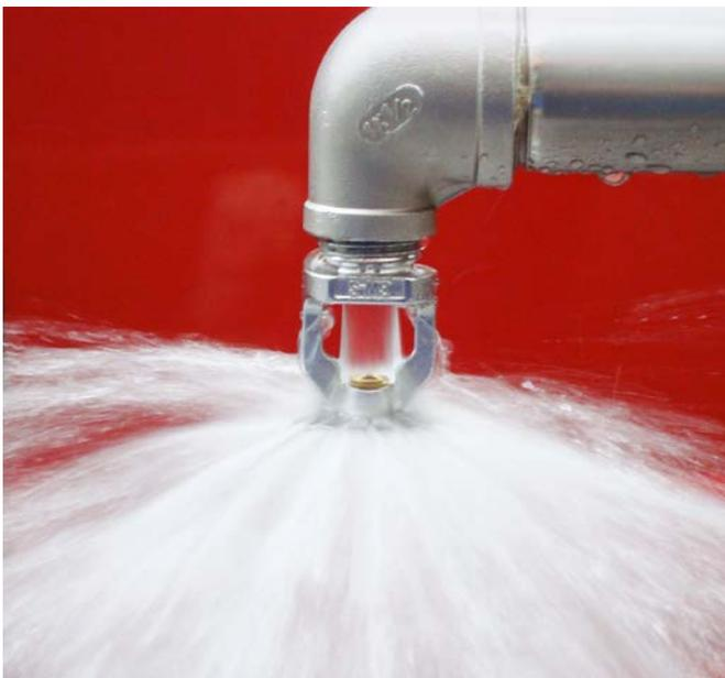
Mit Hilfe von Sprinkleranlagen werden Schutzziele wie die Erkennung und Löschung bzw. das Kontrollieren eines Brandereignisses, die Aktivierung von Brandfallsteuerungen, die interne Alarmierung von gefährdeten Personen sowie die externe Alarmierung der Feuerwehr gewährleistet. Damit diese Schutzziele auch während einer temporären Ausserbetriebsetzung von Sprinkleranlagen sichergestellt bleiben, bedarf es einer frühzeitigen Planung von Sicherheitsmassnahmen und Abläufen.
