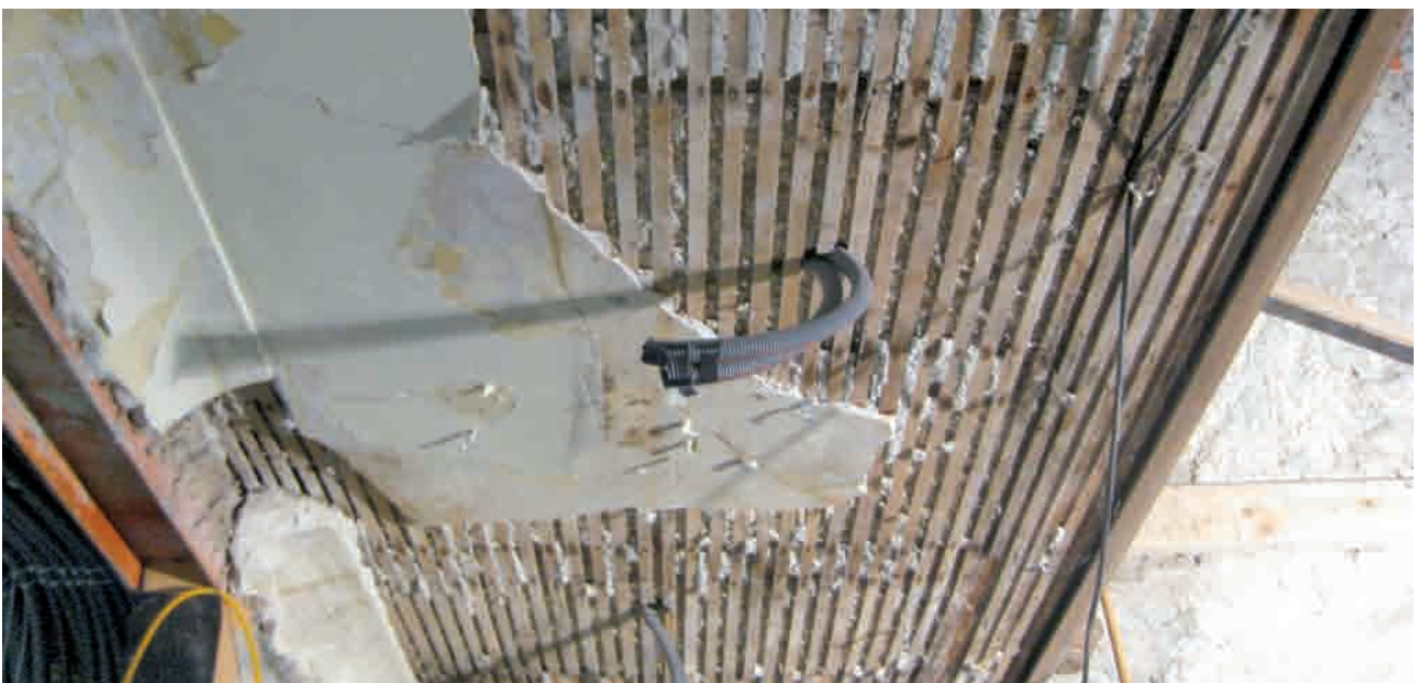
Wiederaufbau Sumpfkalkdecke Zunfthaus Zimmerleuten, 2009
