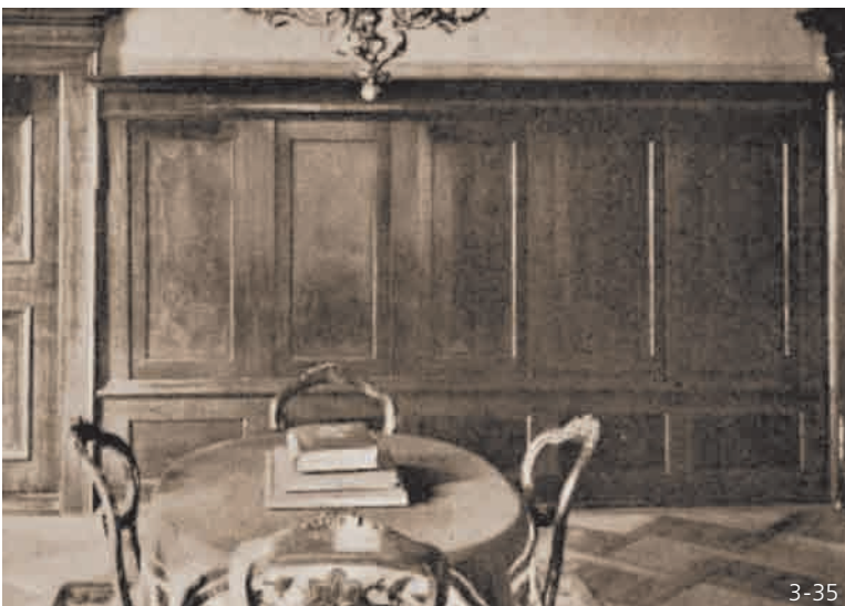
3 Täfer mit profiliertem Rahmen, ehemaliges Haus zum Brunnen, Zürich
