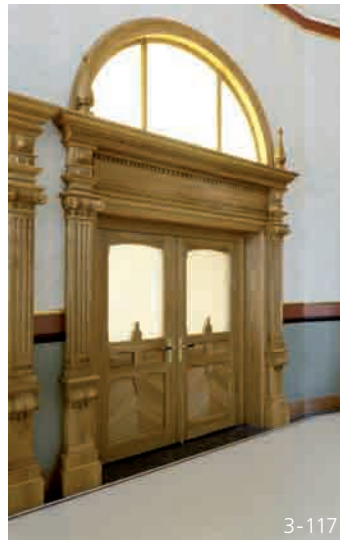
22 Doppeltür mit Fischgratfüllung und Verglasung, Dolder, Zürich
