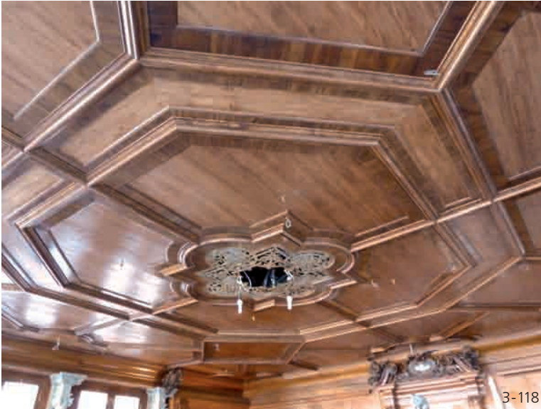
15 Decke, Zunftsaal zur Zimmerleuten, Zürich
