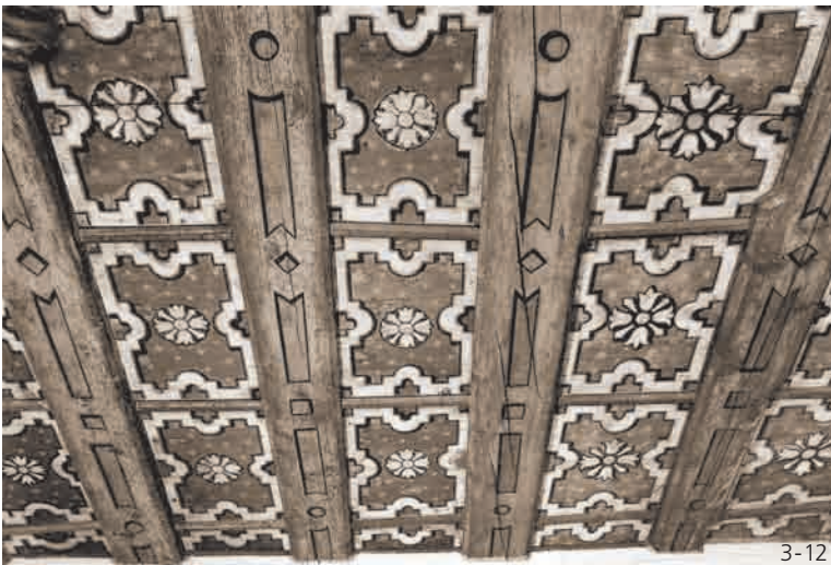
10 Alte Kanzlei, Oberstammheim
