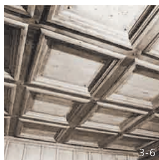
5.1 Kassettendecke, Wohnhaus, Zollikon
