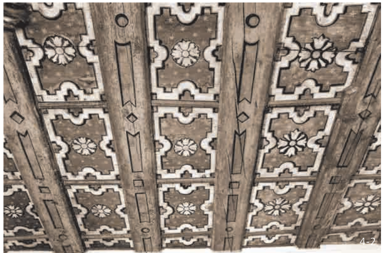
2 Alte Kanzlei, Oberstammheim
