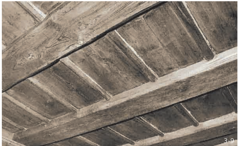
7 Wohnhaus (abgebrochen), Flaach
