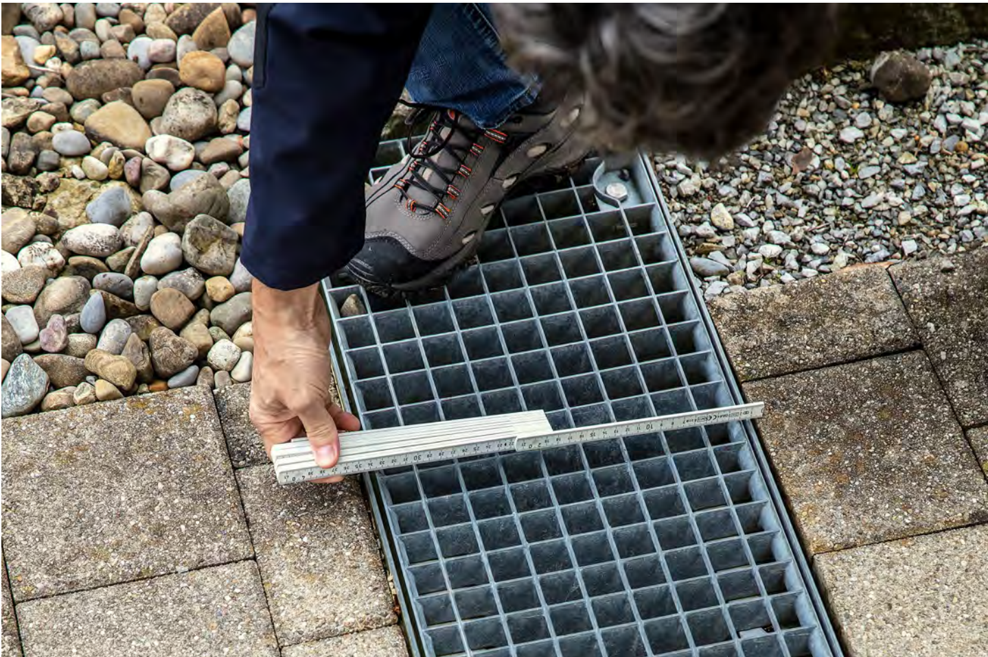
Grosszügig dimensionierte Entwässerungsrinnen tragen wesentlich zur Schadenminderung bei häufigen und starken Niederschlagsereignissen bei.
