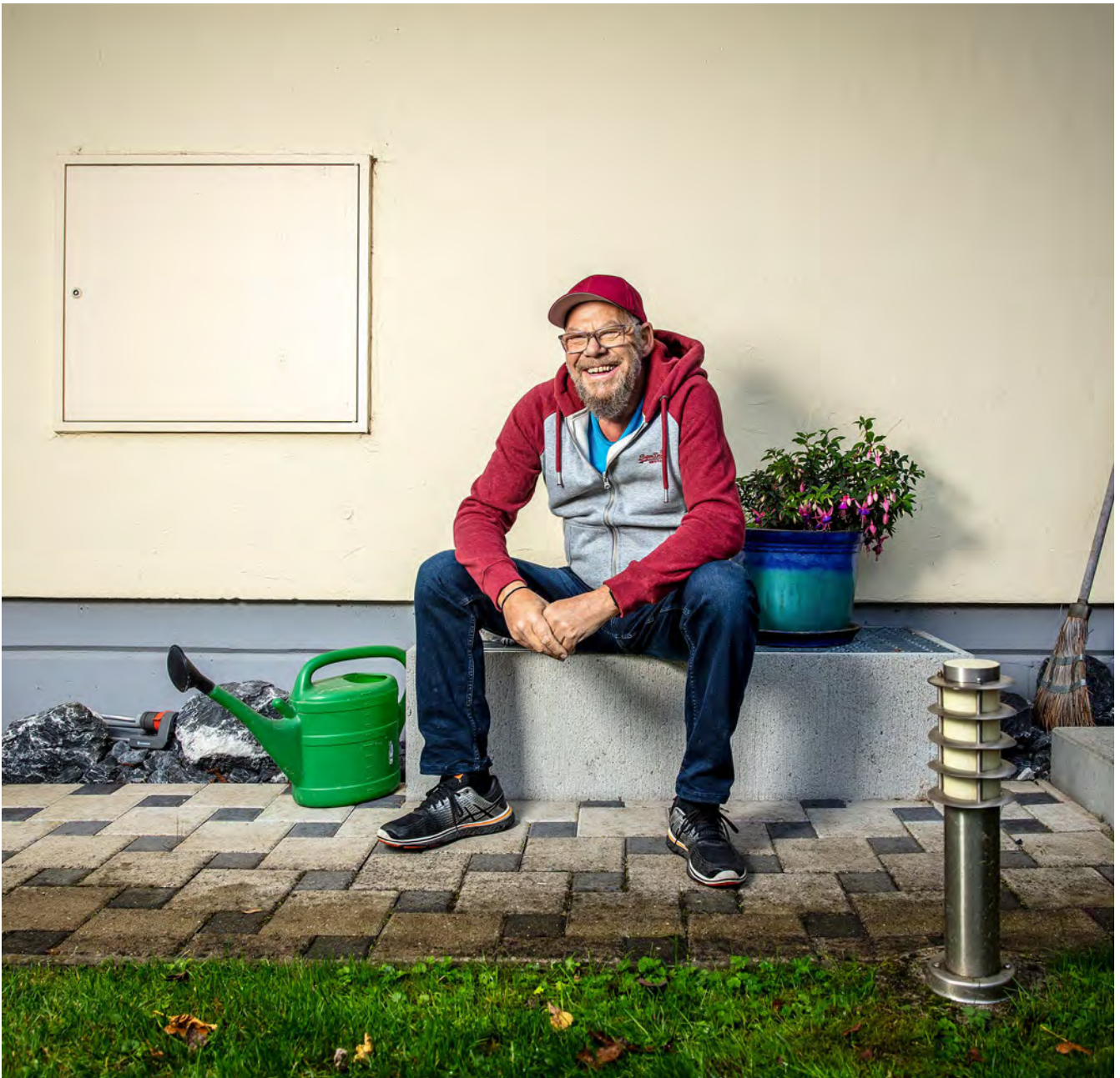
Jörg Lang sitzt auf einem erhöhten Lichtschacht – eine wirksame Schutzmassnahme gegen Hochwasser.
