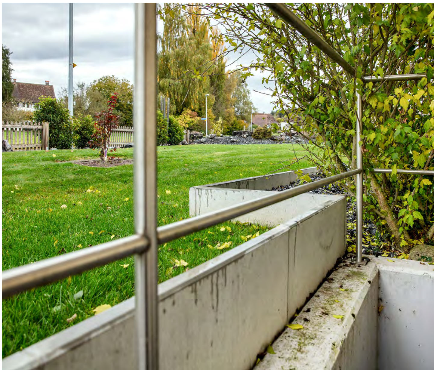
Sockelmauern schützen den Keller dieses Einfamilienhauses vor dem Eindringen von Wasser.
